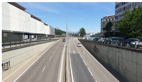
Voie centrale passant sous la place de l'étoile
