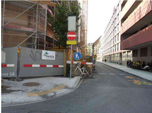
Figure 20 : obligation de traverser la route sans passage piéton
