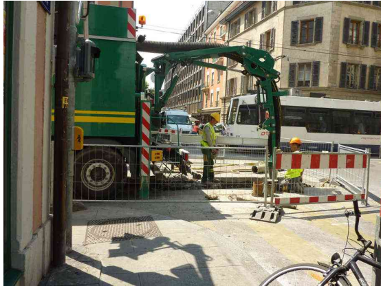
Figure 29 : passage piéton obstrué
