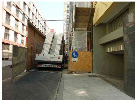
Figure 21 : sortie de camion sur la déviation
