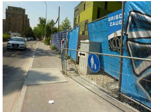
Figure 11 : aménagement pour les PMR
