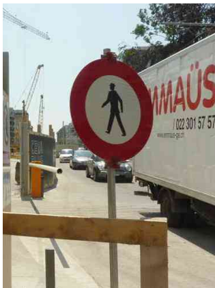
Figure 39 : panneau d'interdiction de continuer pour les piétons, ils doivent emprunter un autre itinéraire
