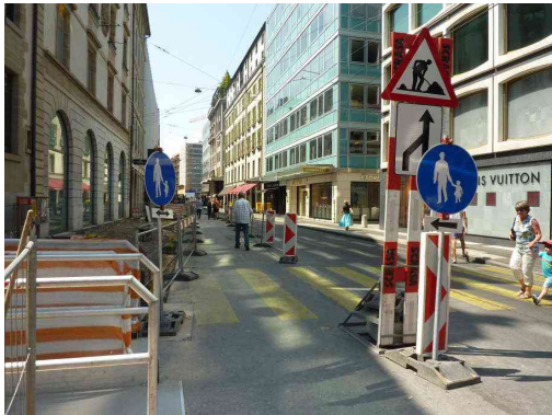
Figure 7 : petits ponts pour PMR
