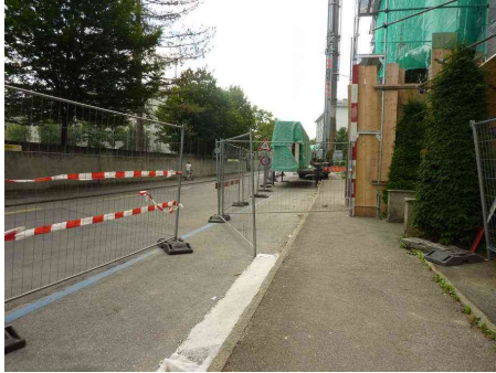
Figure 26 : déviation qui mène tout droit au chantier
