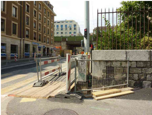
Figure 6 : planches en bois ne facilitant pas le franchissement en chaise roulante
