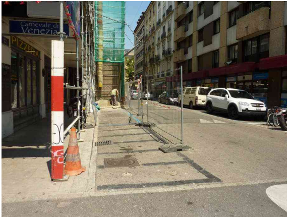
Figure 15 : largeur du trottoir plus ou moins conservée
