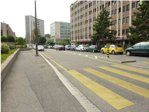
Figure 28 : déviation placée trop loin pour être visible
