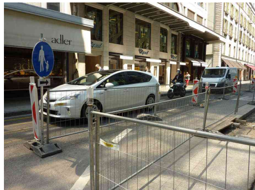
Figure 8 : barrières de sécurité et déviation spécifique
