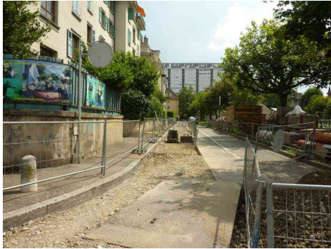
Figure 22 : faible obstruction du trottoir piétons de se rendre sur le chantier et d'être gênés par les machines de chantier ou les voitures.
